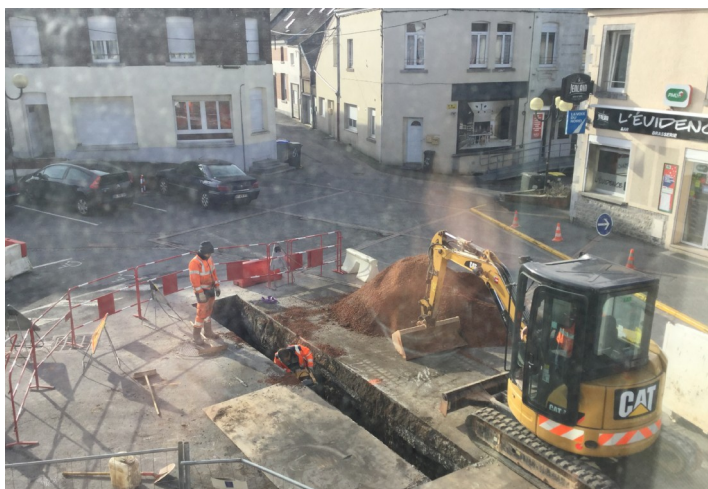
Raccordement des eaux usées de la mairie par l'Agglo
