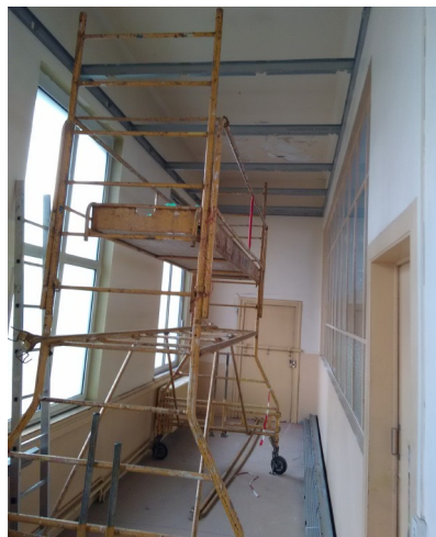
Travaux Maison des associations
