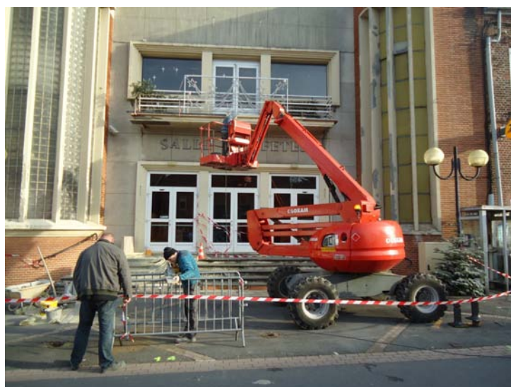
Réparation balcon salle des Fêtes
